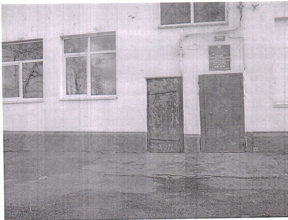
Фото №2: Входа (входов) в здание
